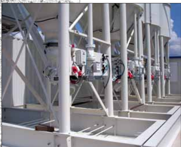
Schnellmontagesilos auf transportablem Fundamentrahmen (vor dem Ausbetonieren) Quick erection silos on transportable foundation frame (before filling in with concrete)
